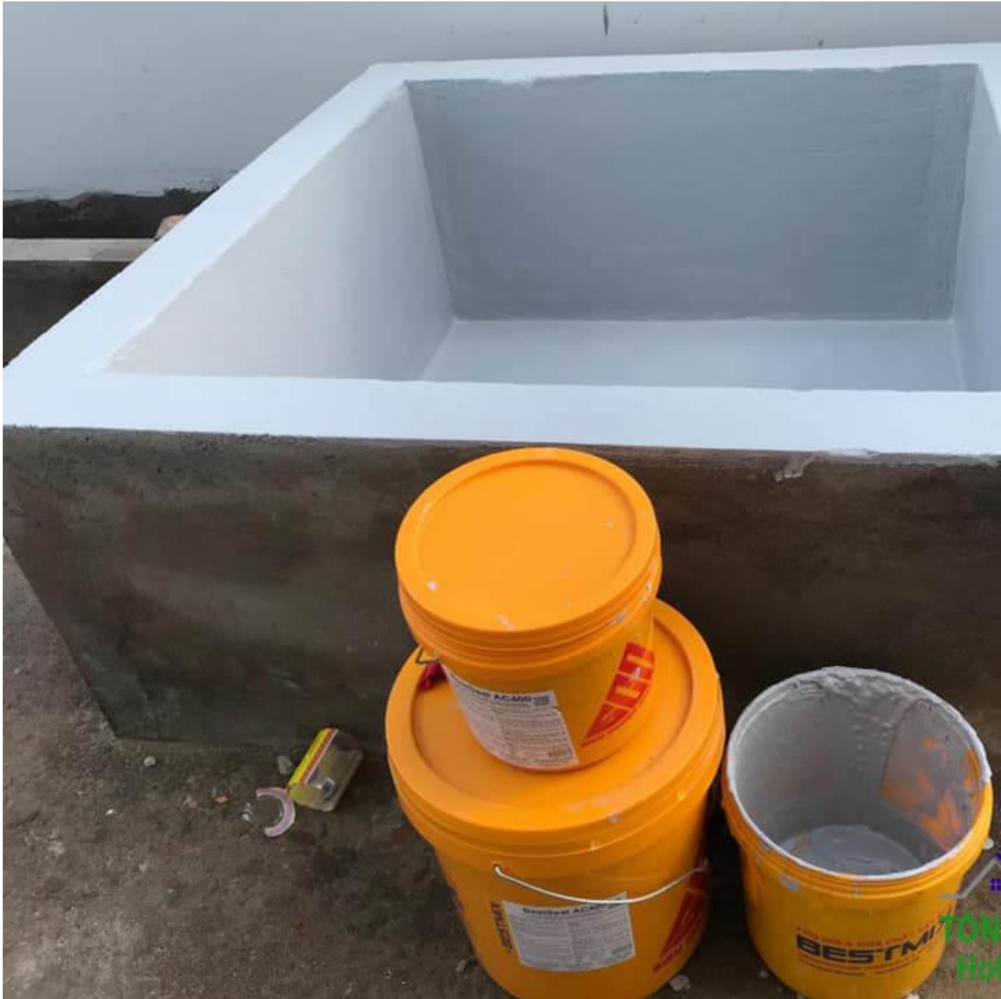
Hiệu quả khi thi công chống thấm
