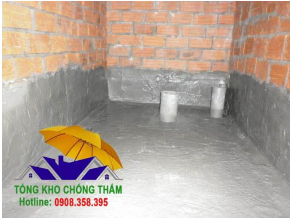
Hiệu quả khi thi công chống thấm
