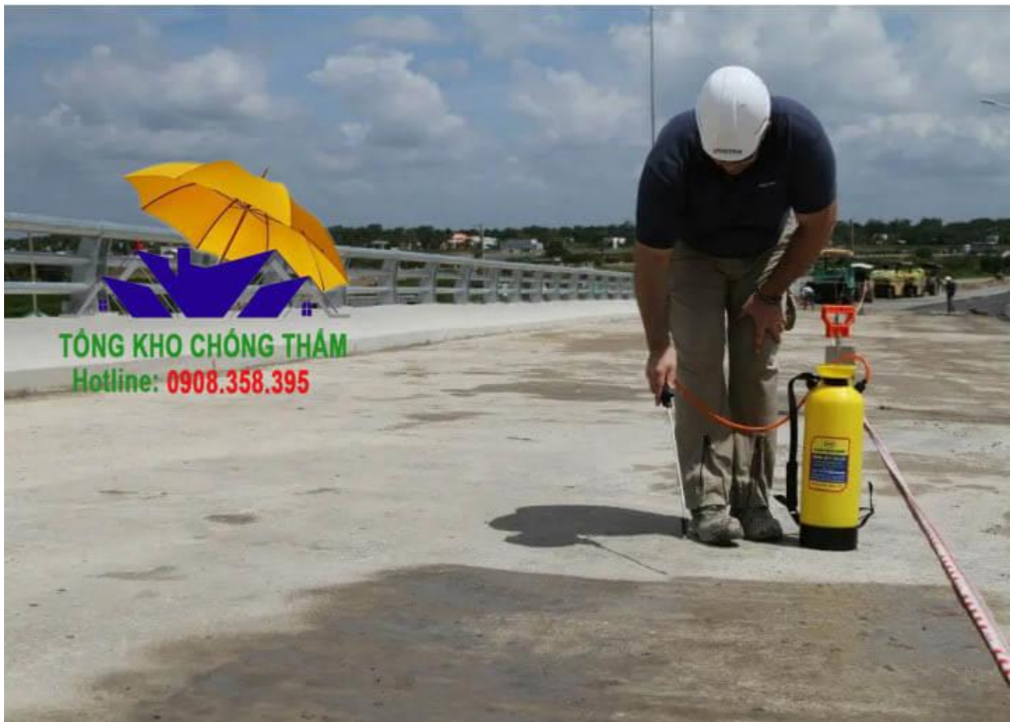
Cách thi công chống thấm Inconseal.31
