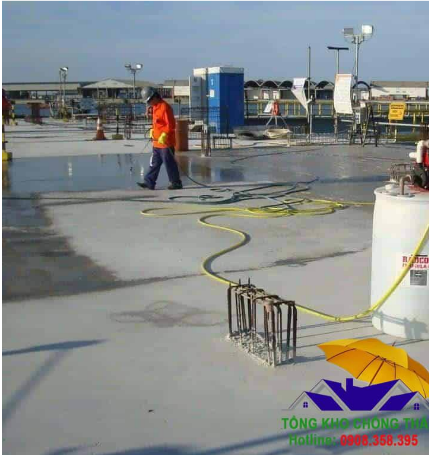
Chống thấm sàn mái bằng Radcon 7
