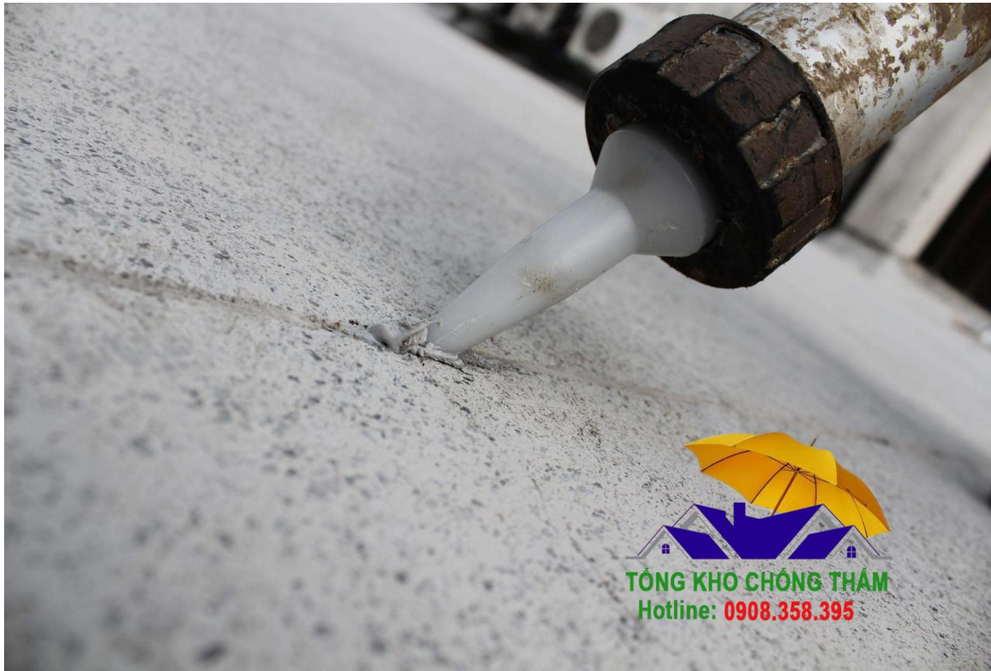
Hướng dẫn cách thi công
