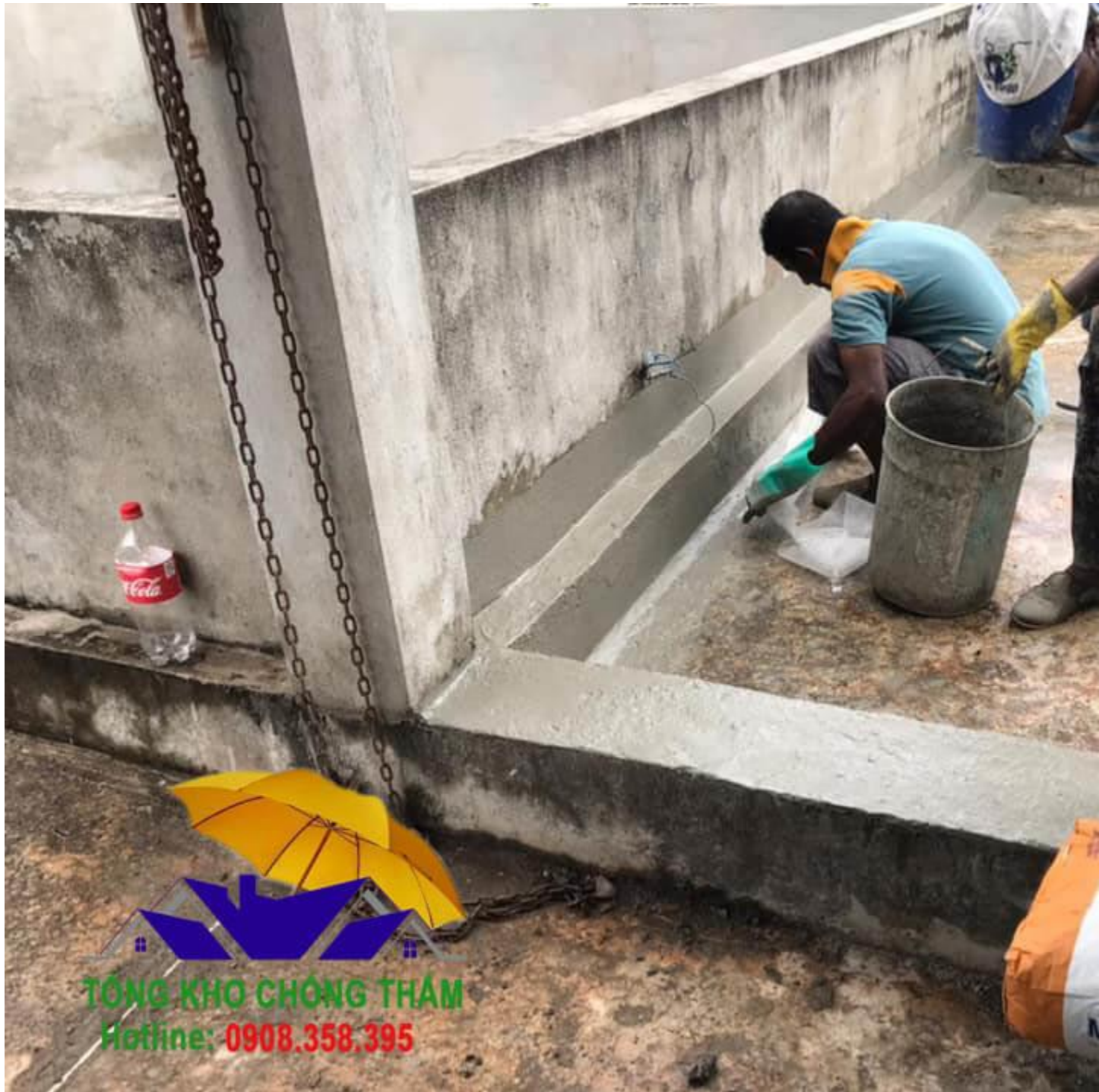
Chống thấm 2 thành phần được dùng ở đây
