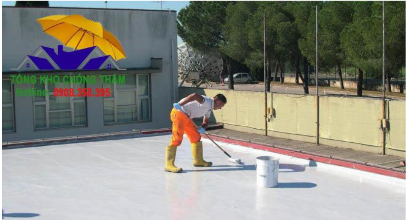
Hướng dẫn cách thi công sơn chống thấm
