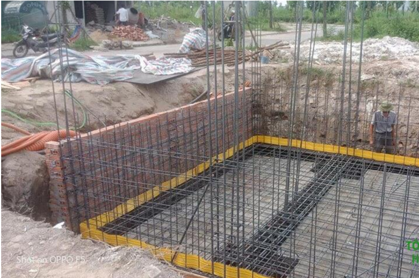
Cách thi công băng cản nước mạch ngừng
