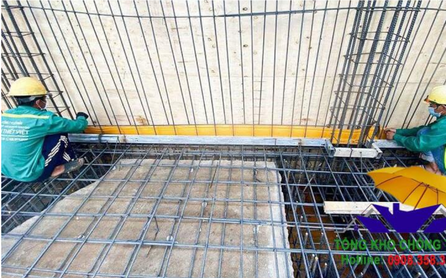
Thi công băng cản nước mạch ngừng
