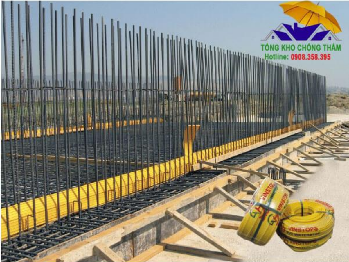
Quy trình thi công
