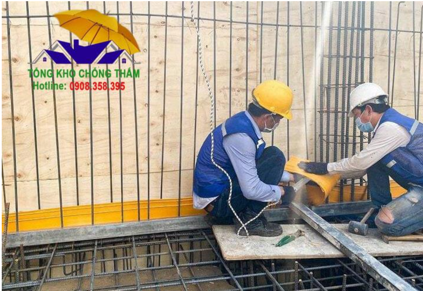
Thi công băng cản nước mạch ngừng
