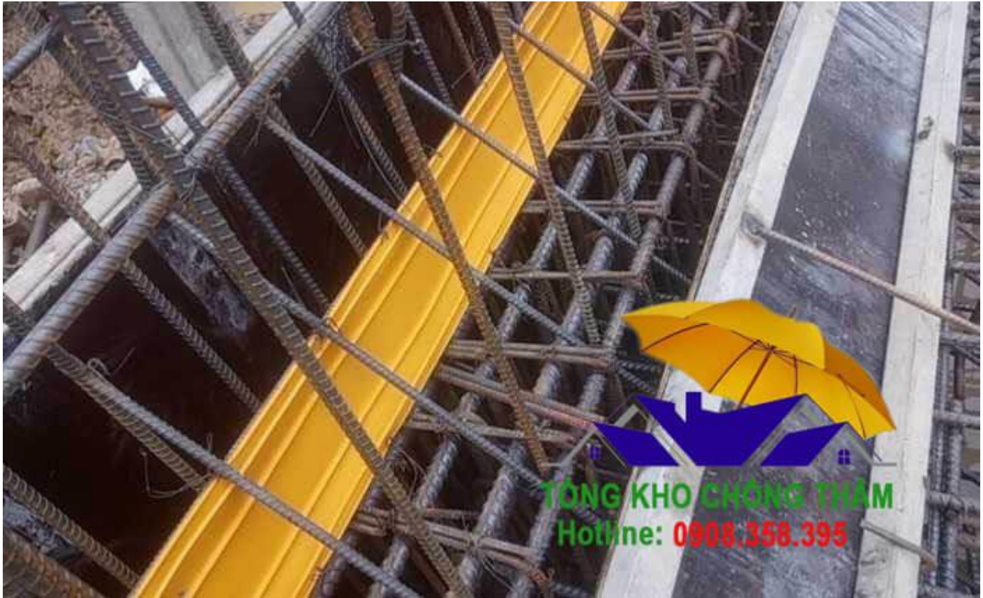
Sử dụng bằng cản nước chống thấm như thế nào
