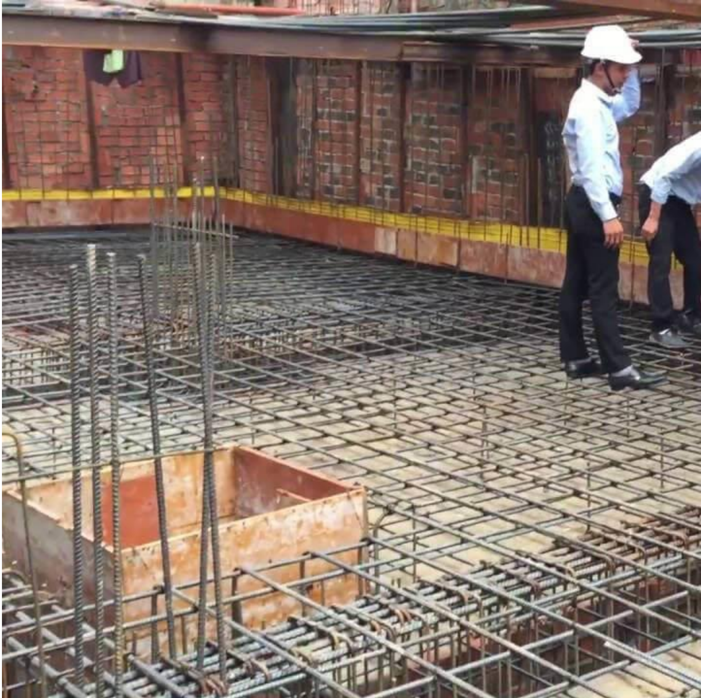
Thi công mạch ngừng
