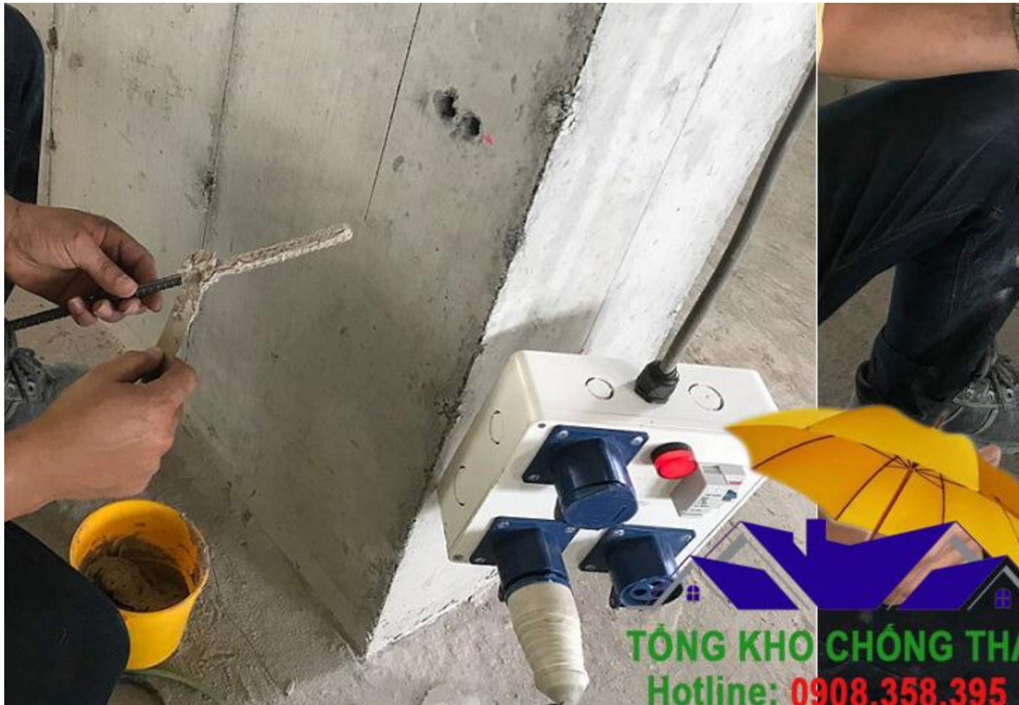
Tiến hành thi công
