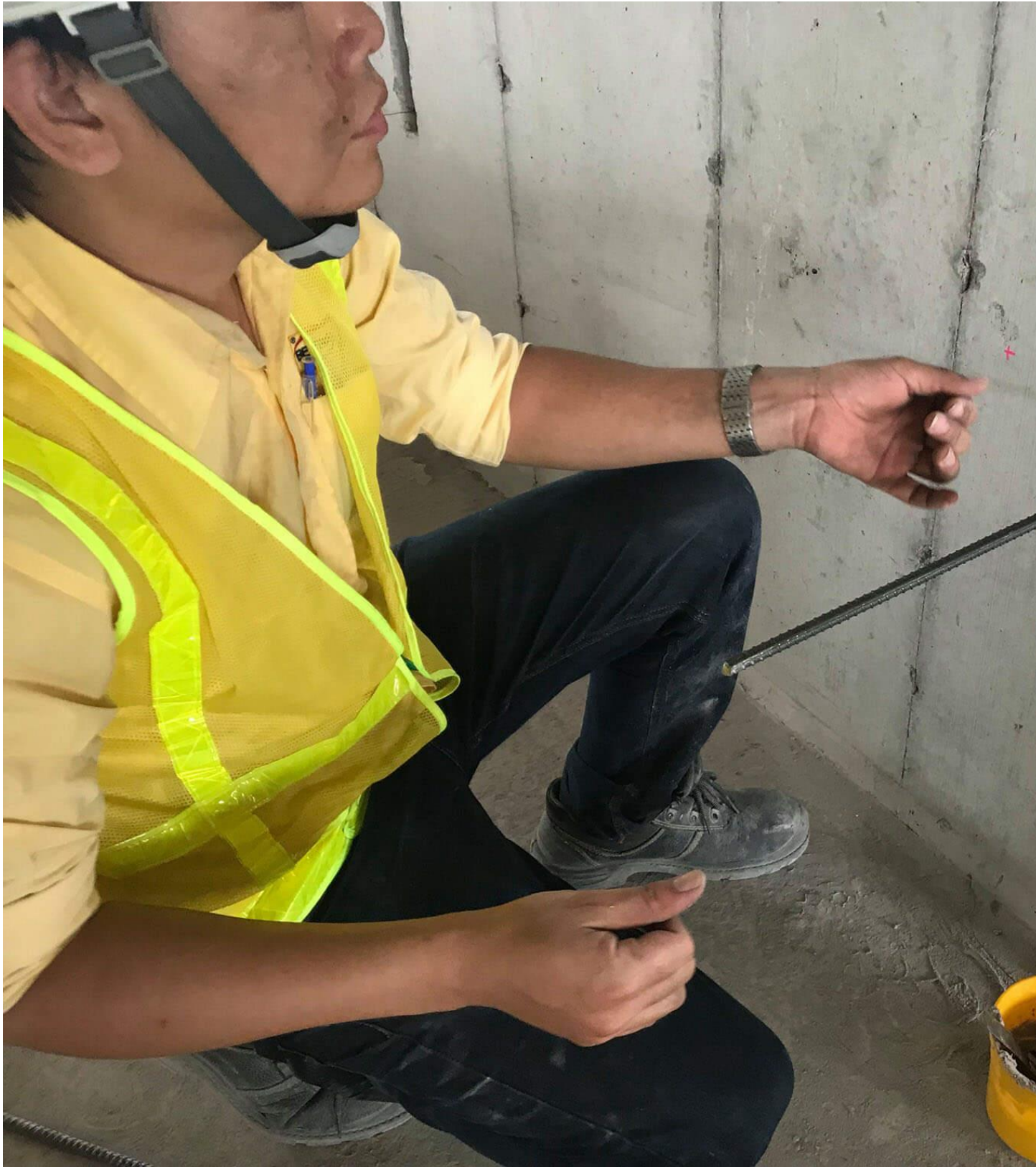
Hướng dẫn cách thi công
