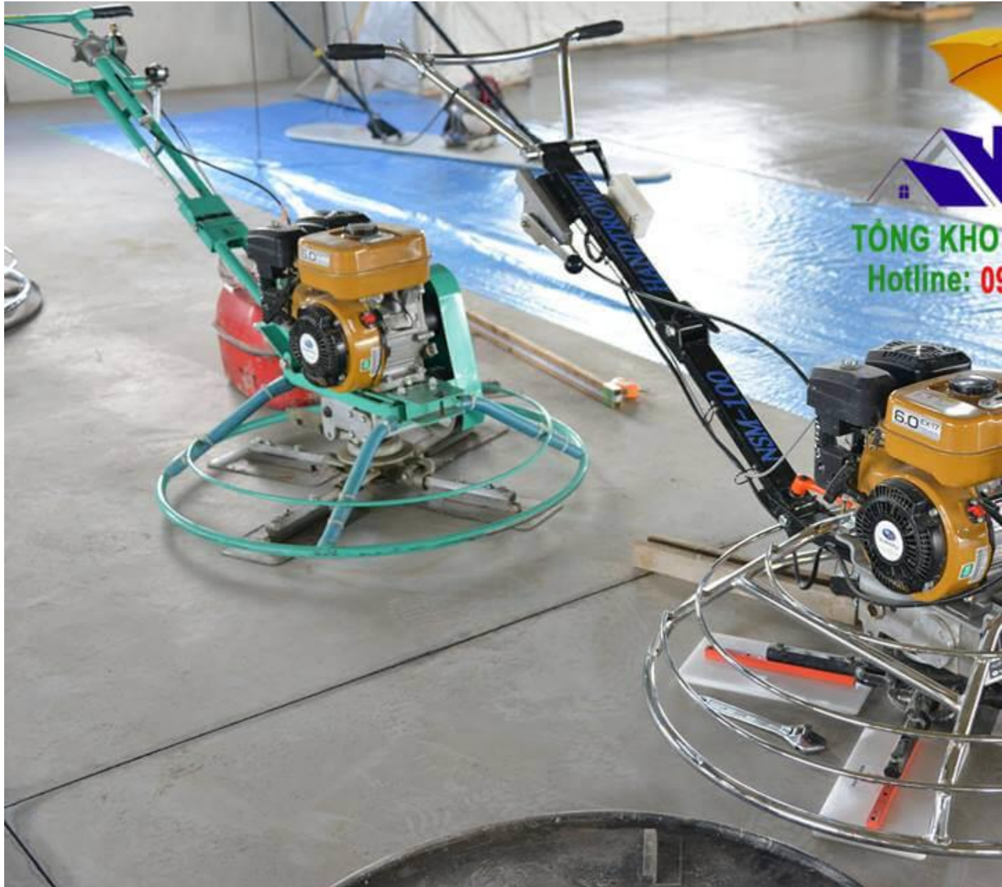
Thi công xoa nền tầng cứng
