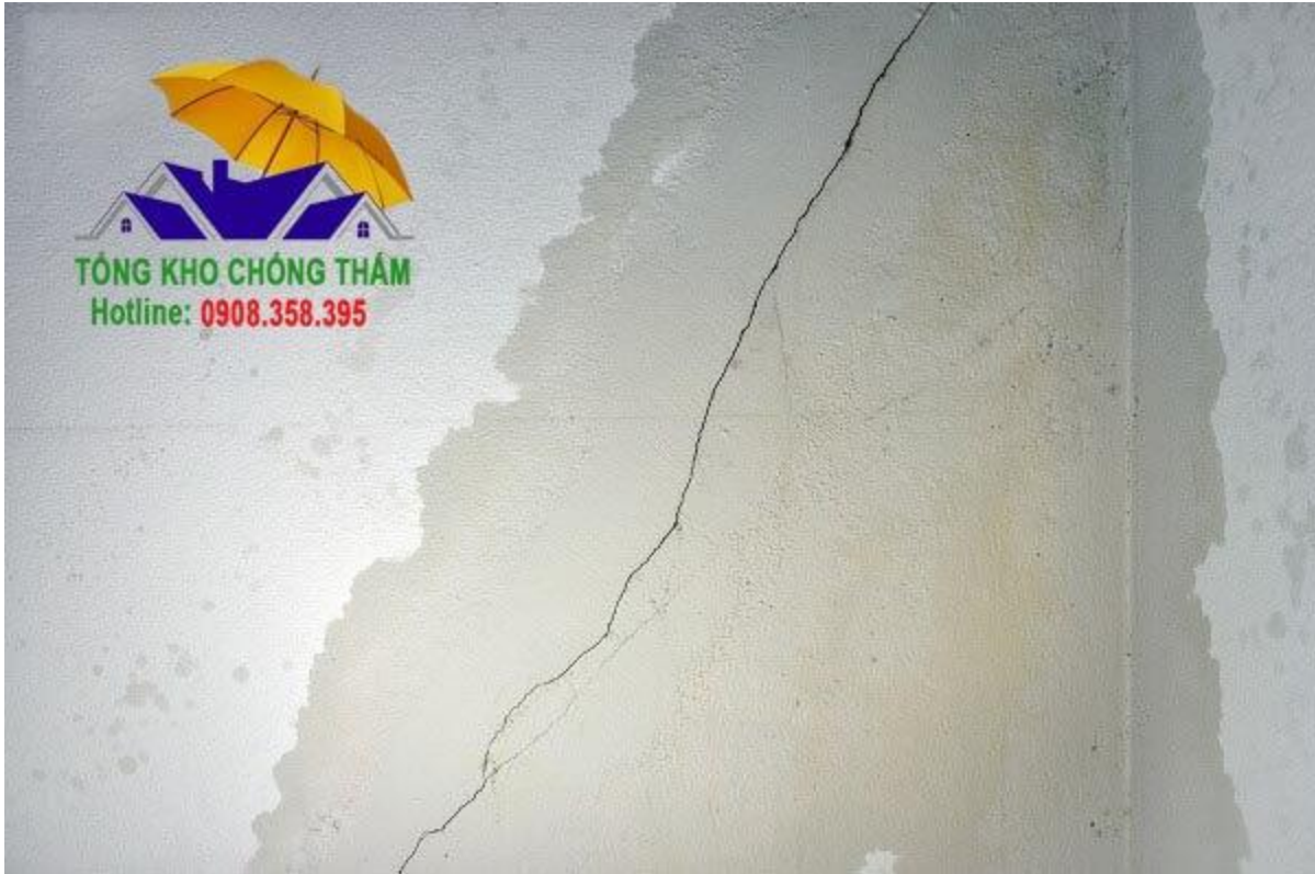
Chống thấm tường nhà bị nứt
