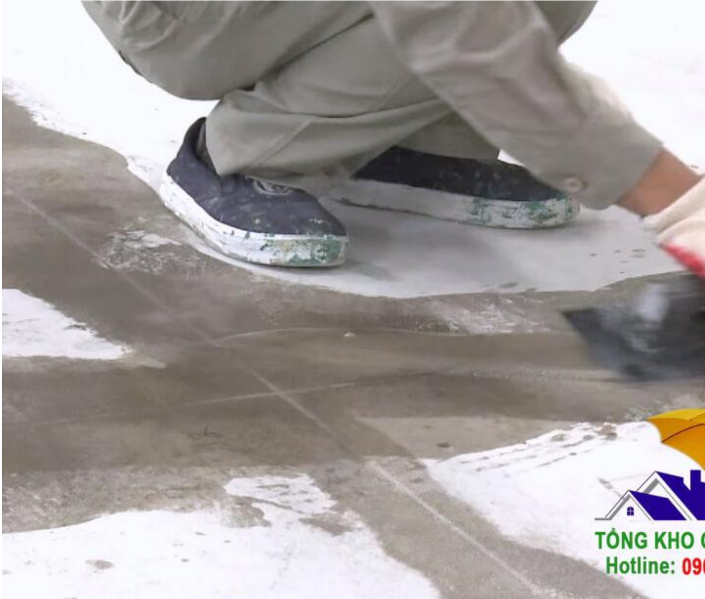
Xử lý nền bê tông bằng MTKL5
