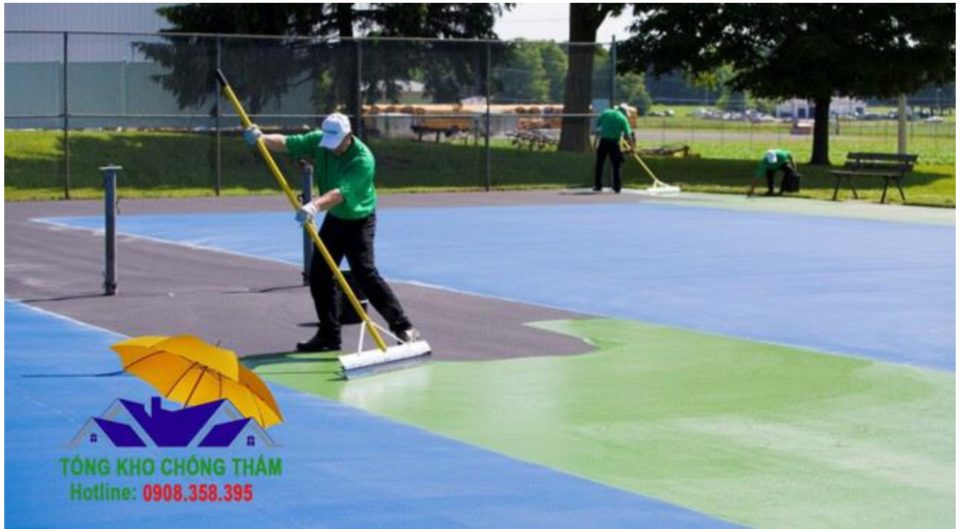
Thi công sơn Kova CT 08
