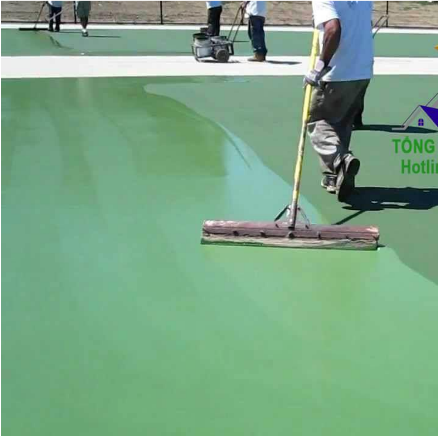
Hình ảnh khi thi công
