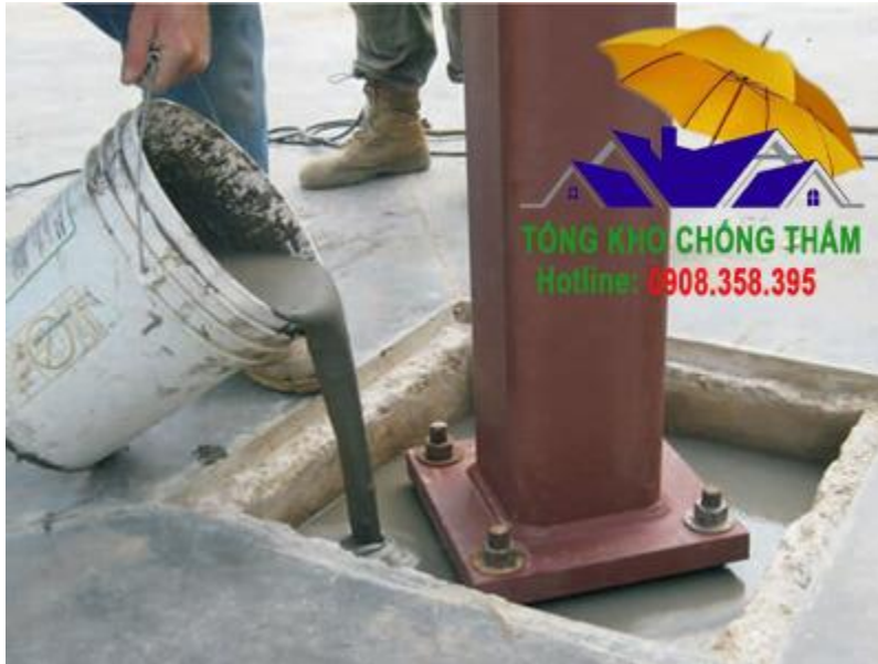
Thi công vữa rót không co ngót
