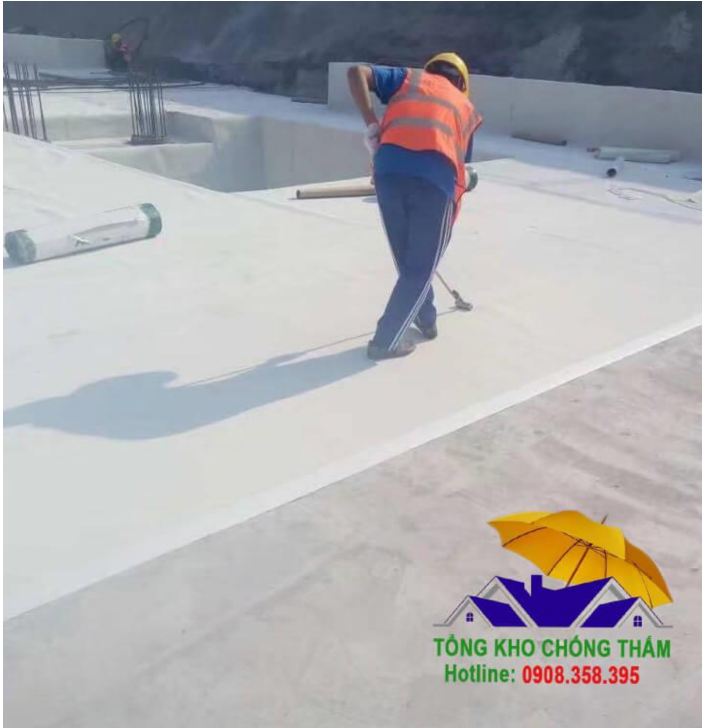
Hình ảnh thi công
