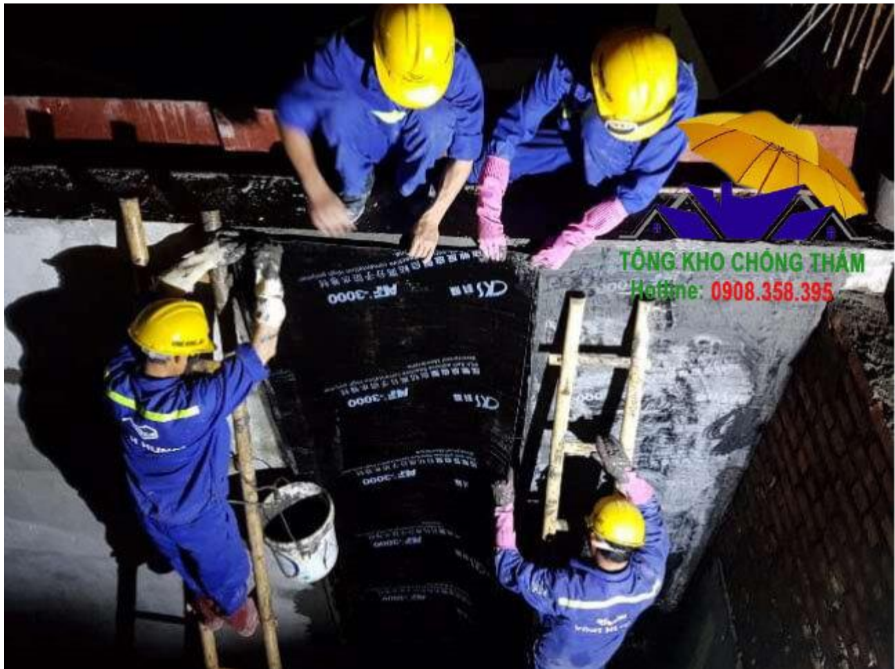
Hình ảnh thi công
