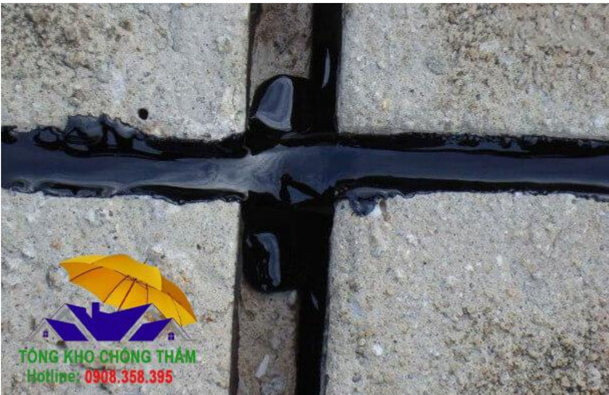
Hình ảnh thi công
