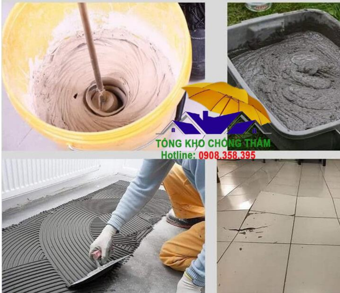
Quy trình thi công
