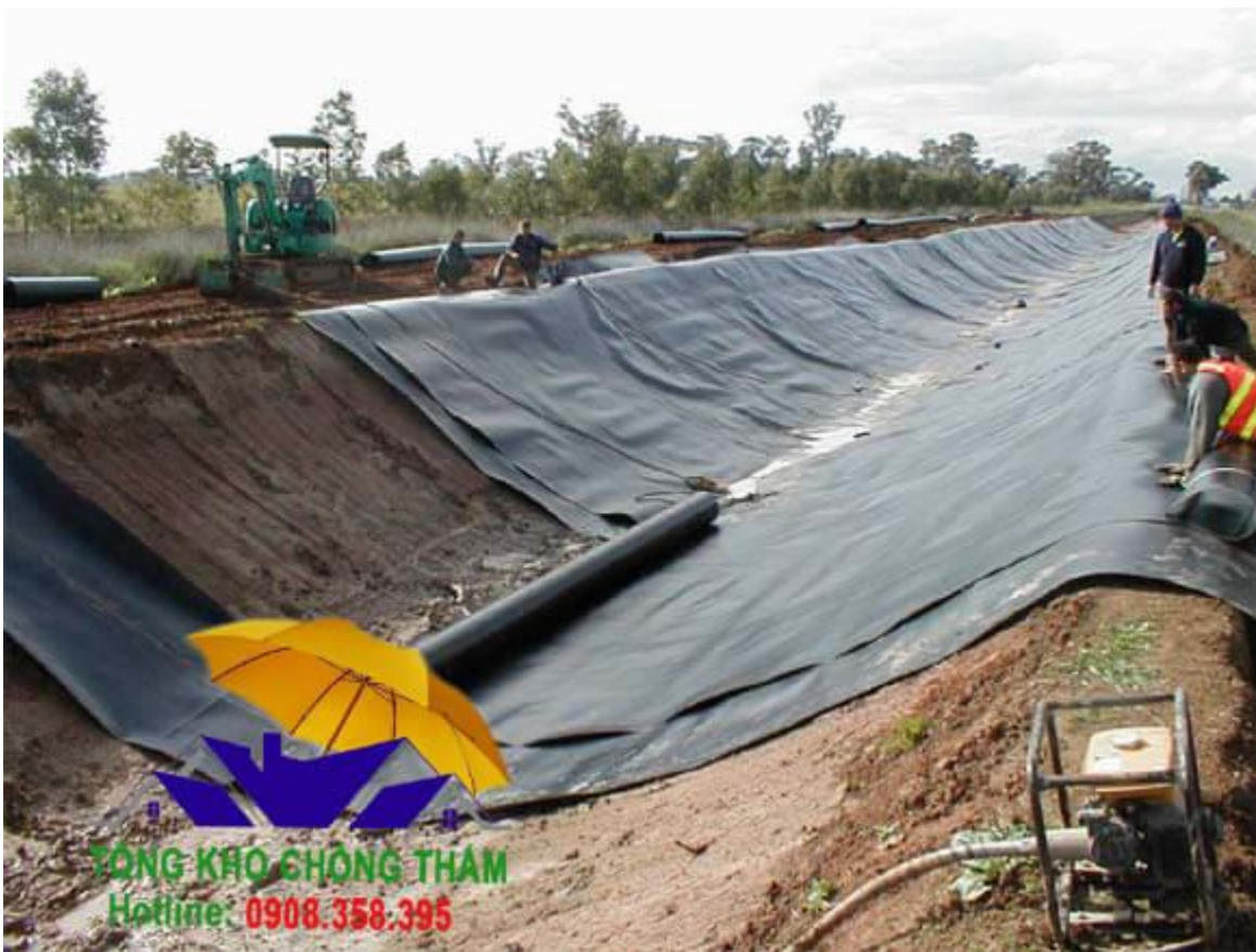
Chống thấm kênh mương
