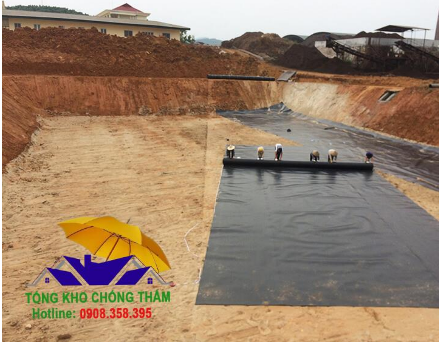
Hình ảnh thi công
