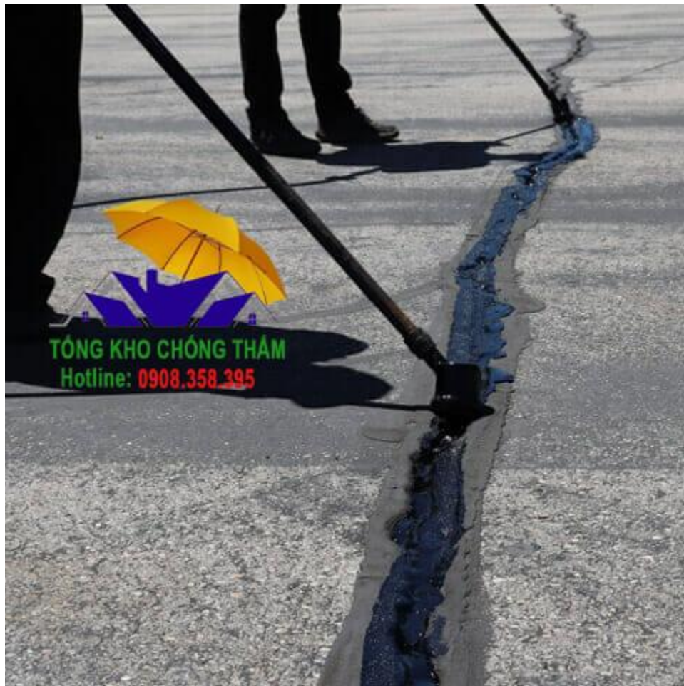
Hình ảnh thi công
