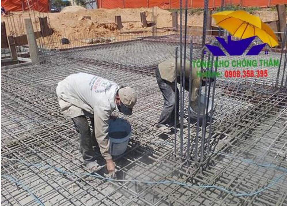
Hình ảnh thi công
