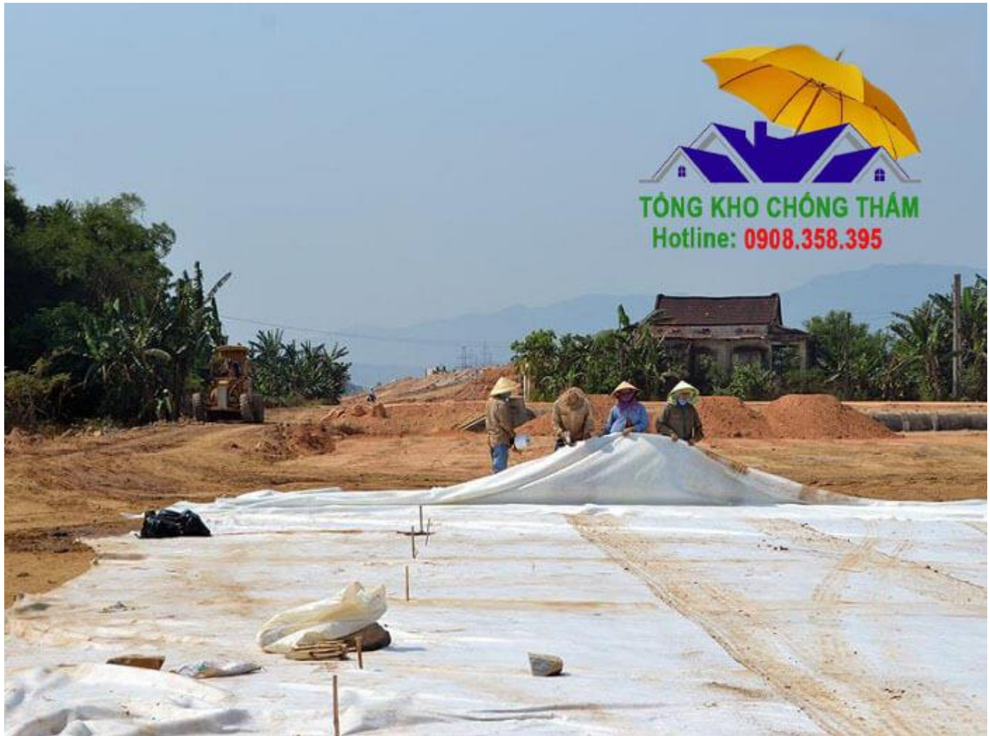
Hình ảnh thi công
