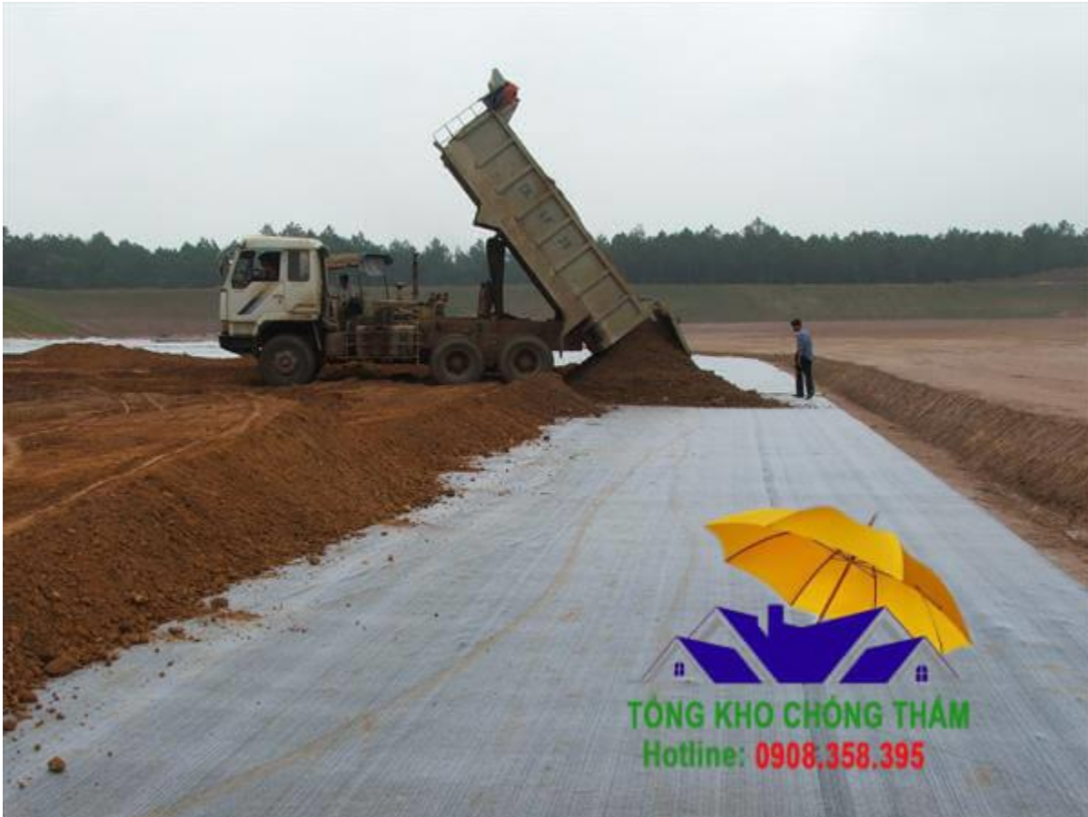
Hình ảnh thi công
