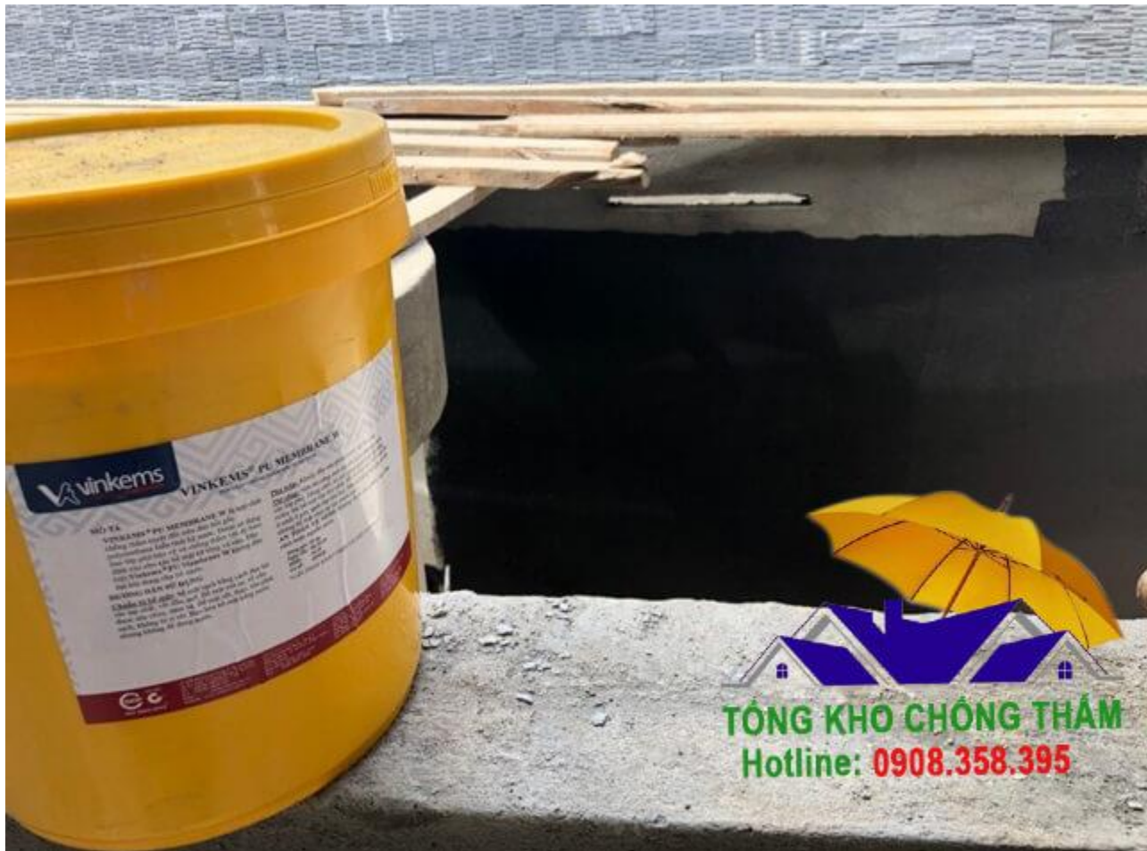
Hình ảnh thi công
