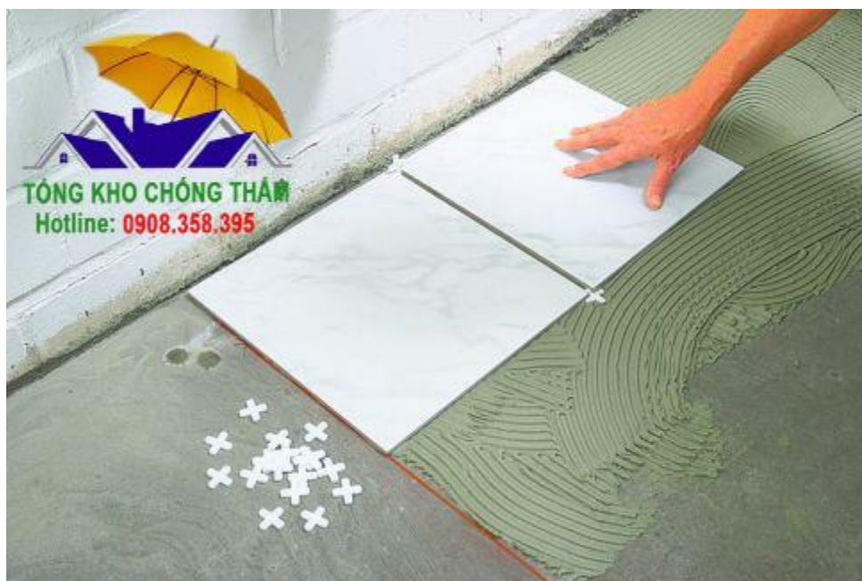
Hình ảnh thi công
