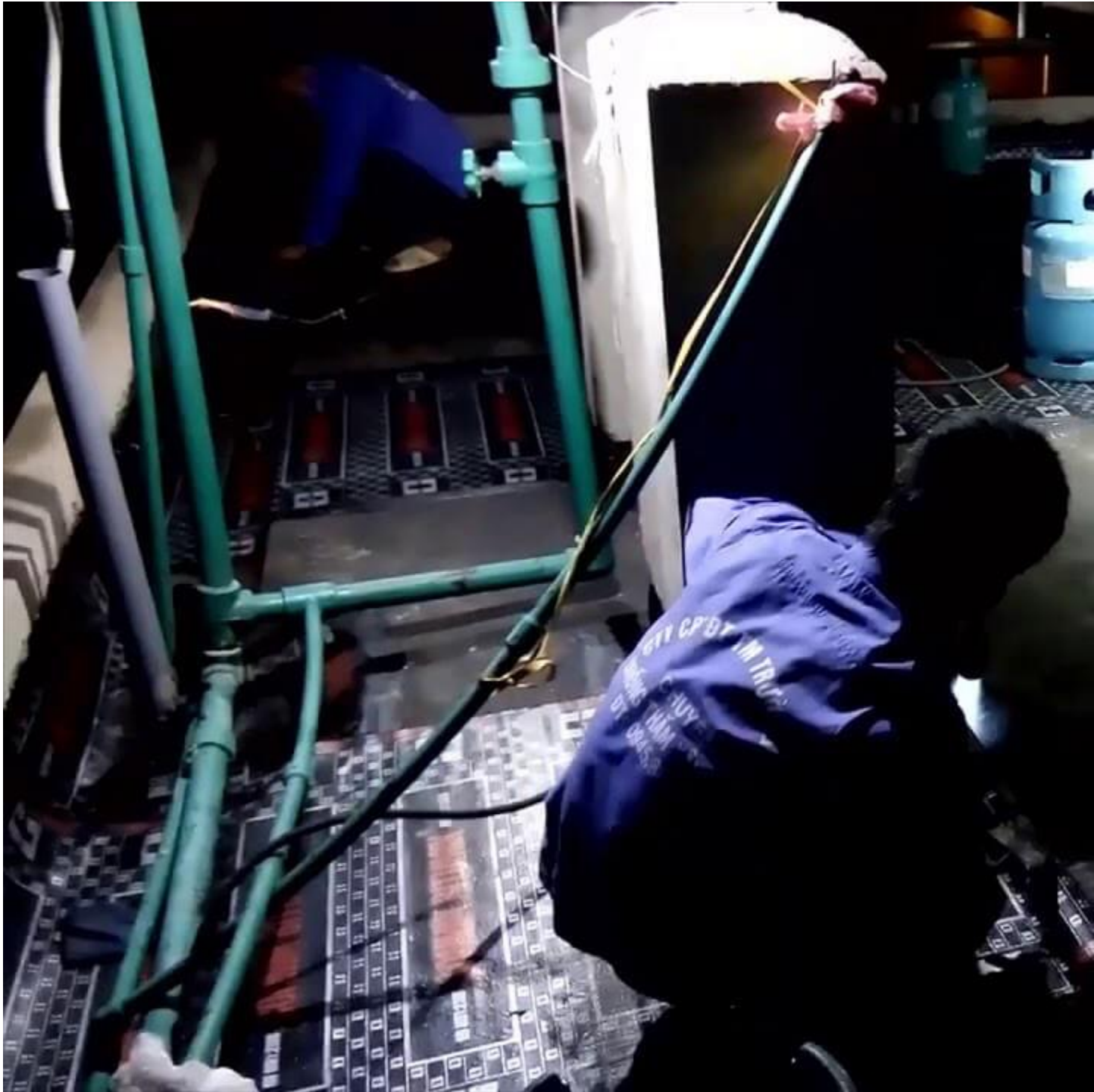
Chống thấm sàn mái
