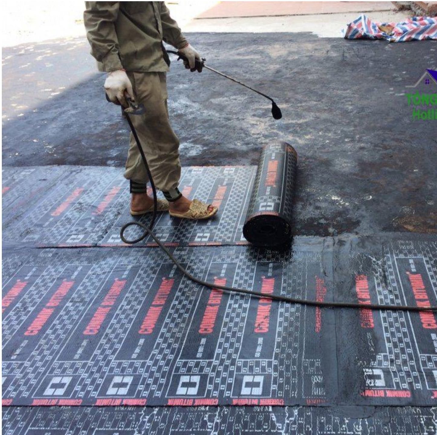
Cách thi công màng
