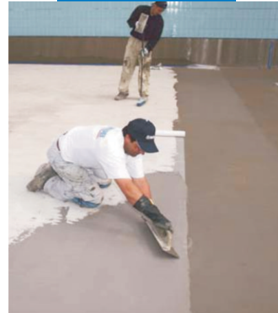
Chống thấm cho bể bơi sử dụng Mapelastic
