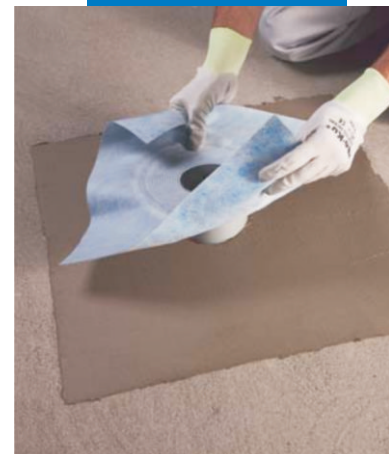
Lắp đặt ống dẫn nước trên Mapelastic
