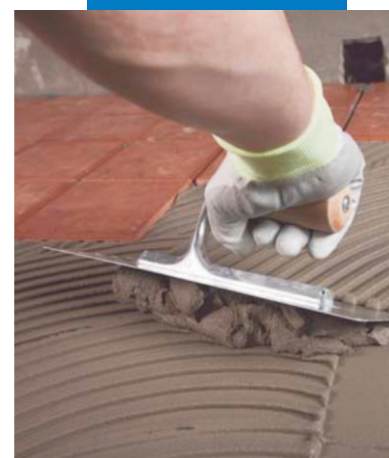
Thi công Granirapid lên sàn thượng đã được chống thấm bằng Mapelastic
