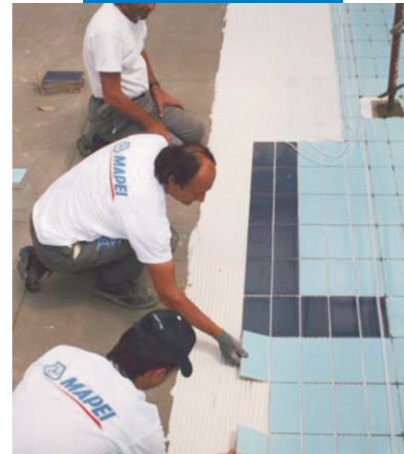
Ốp lát gạch ceramic trên lớp Mapelastic ở bể bơi
