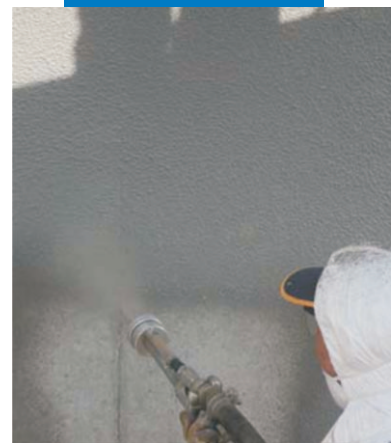
Hình ảnh Mapelastic được thi công chống thấm cho cầu bằng phương pháp phun
