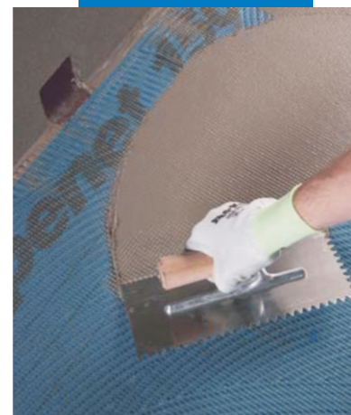
Thi công Mapelastic trên Mapenet 150
