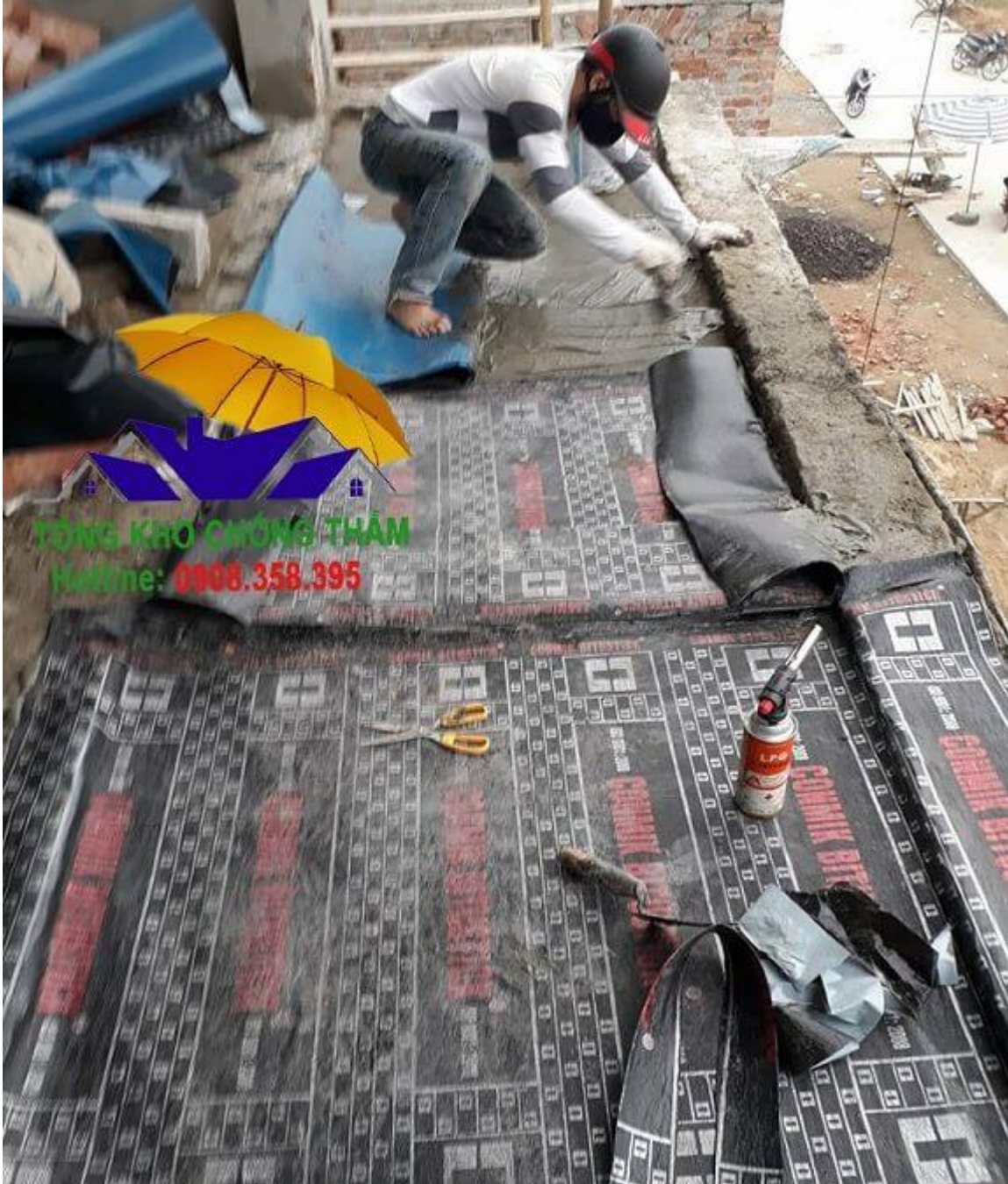
Chống thấm ban công
