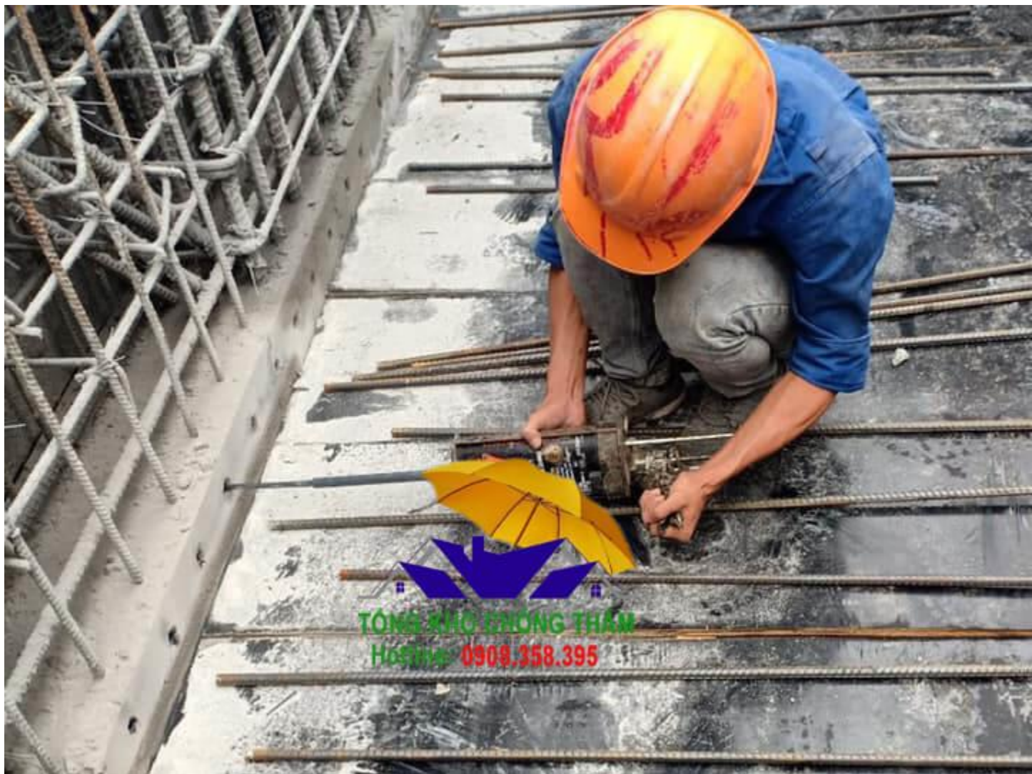
Thi công cấy thép Ramset
