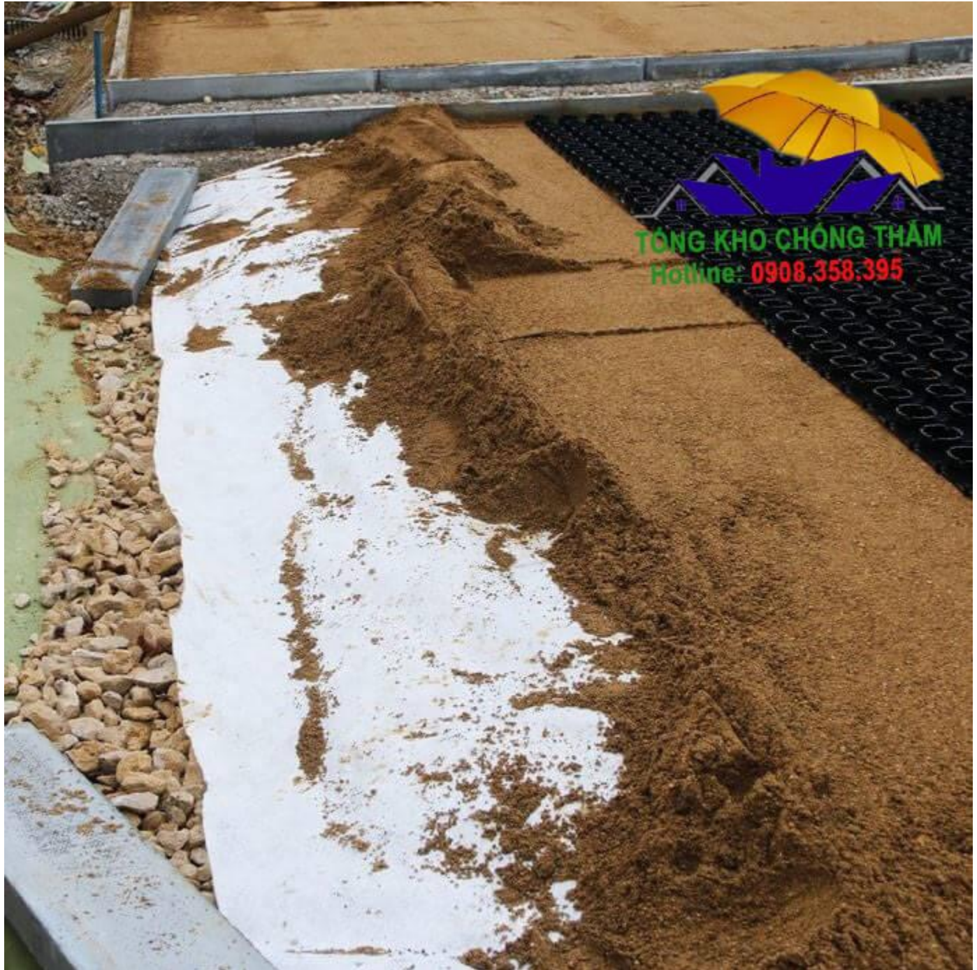
Hình ảnh thi công
