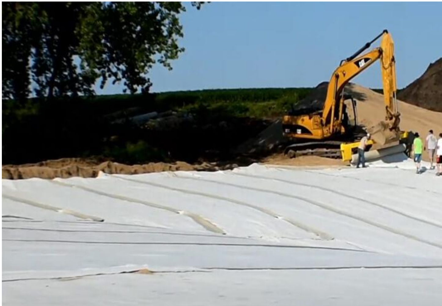
Thi công vải địa kỹ thuật ART
