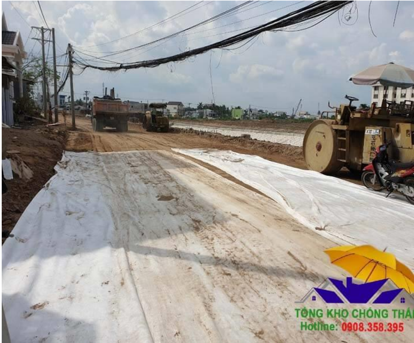
Trải vải địa đúng cách
