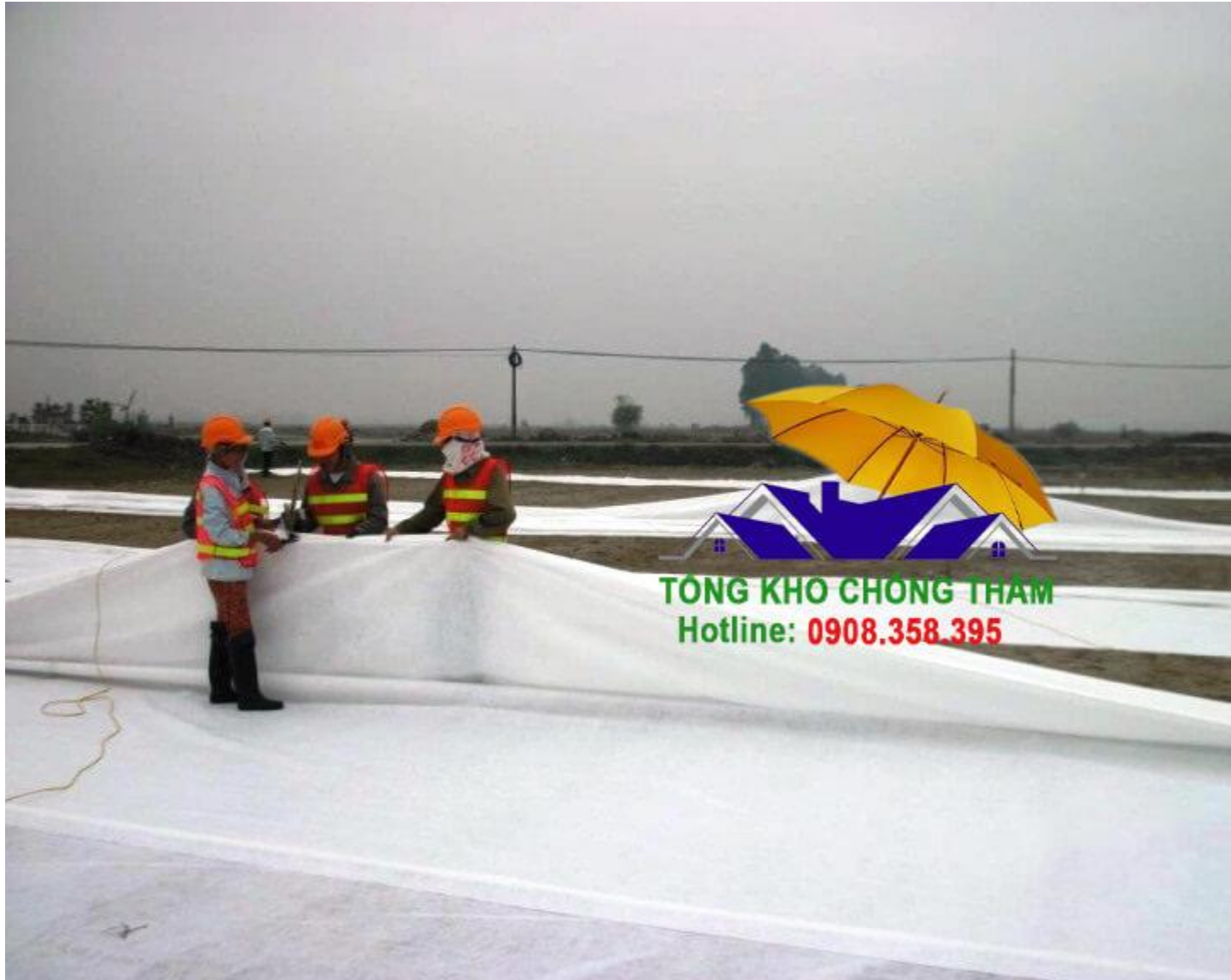
Nối vải địa kỹ thuật
