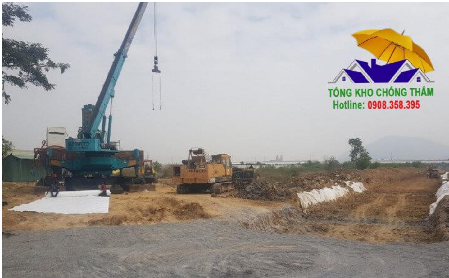
Thực hiện thi công tại công trường
