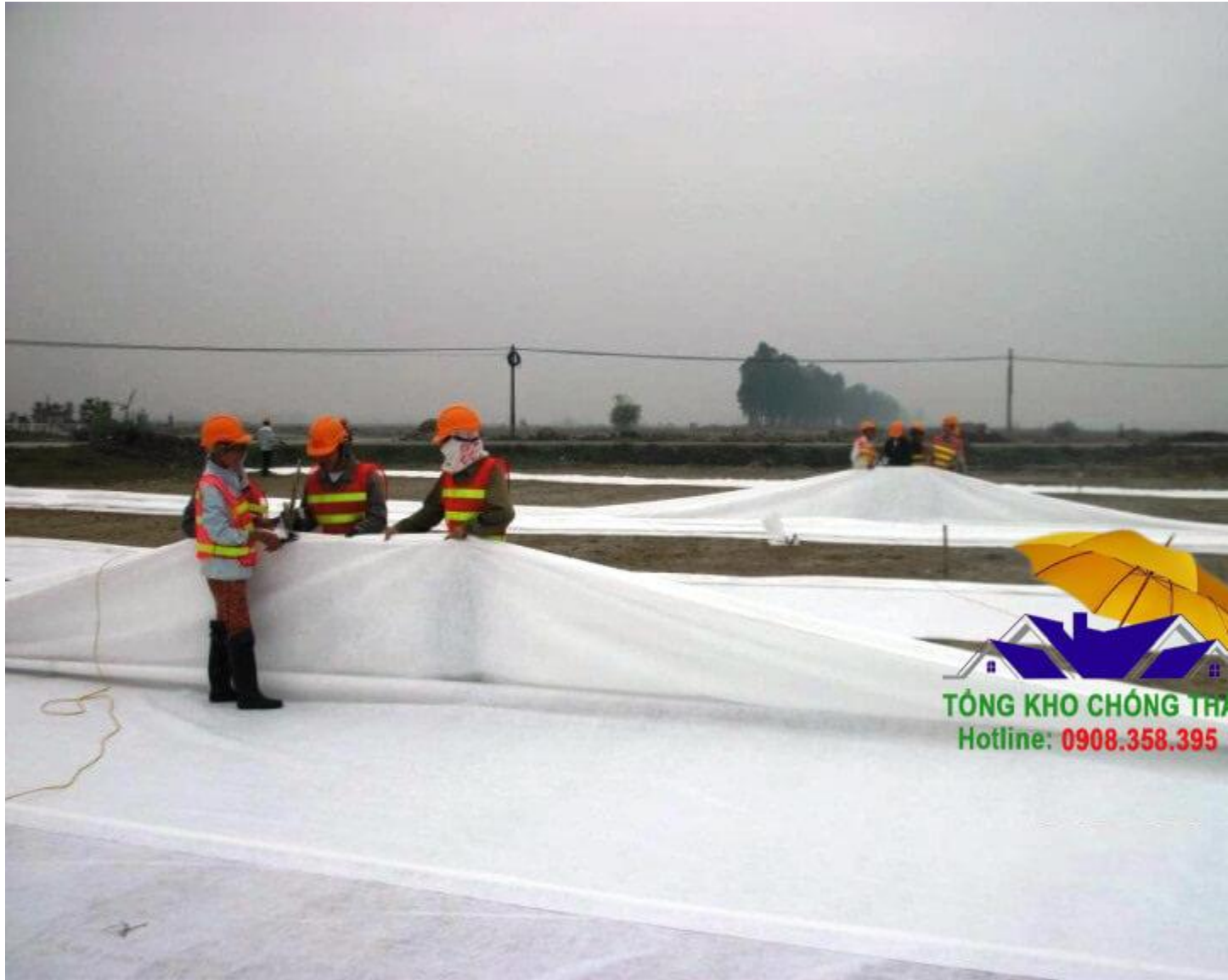
Công tác nối vải không dệt
