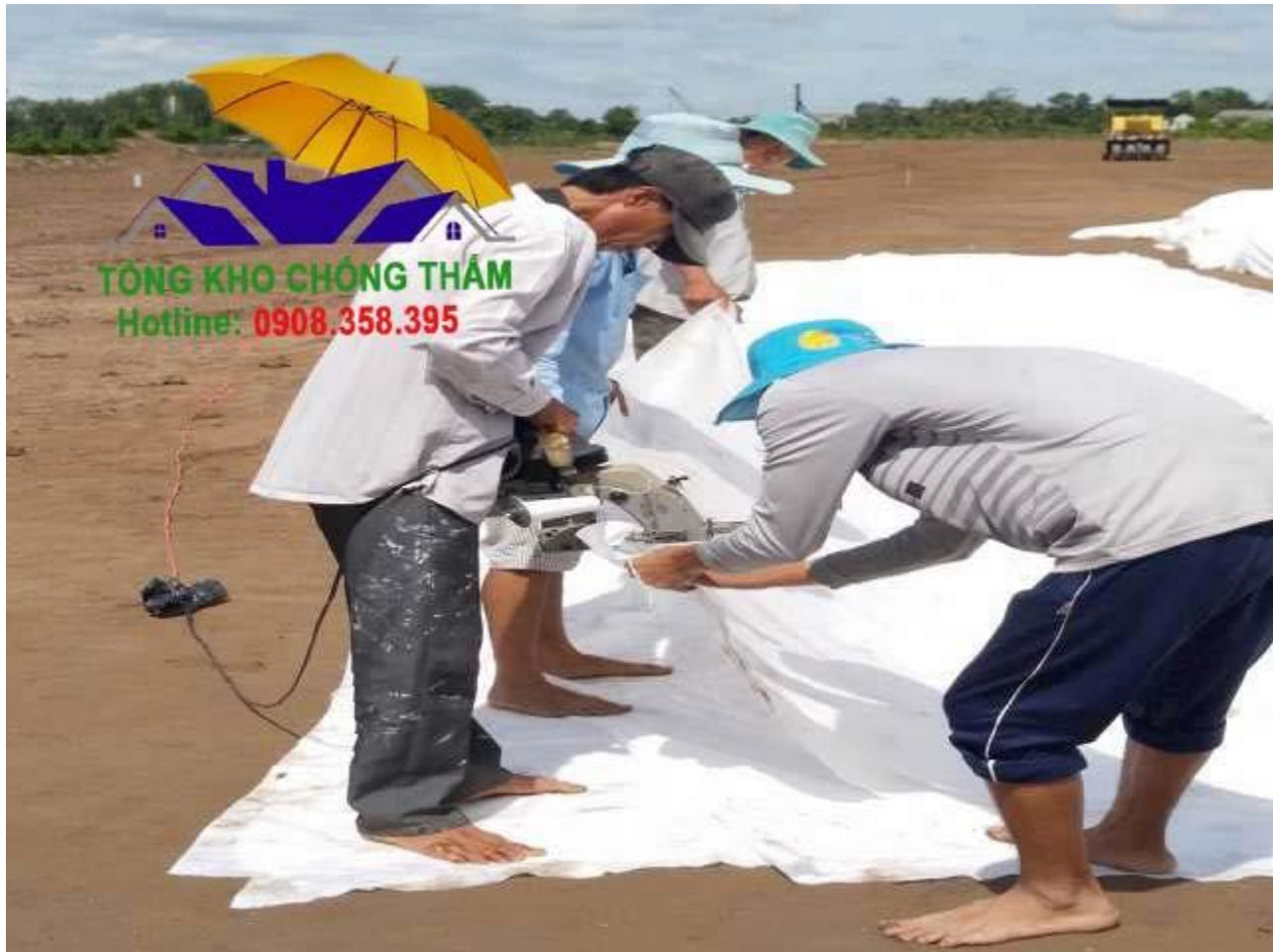
Nối may vải địa
