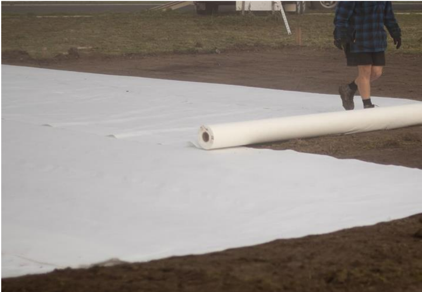
Rải vải địa ART không dệt
