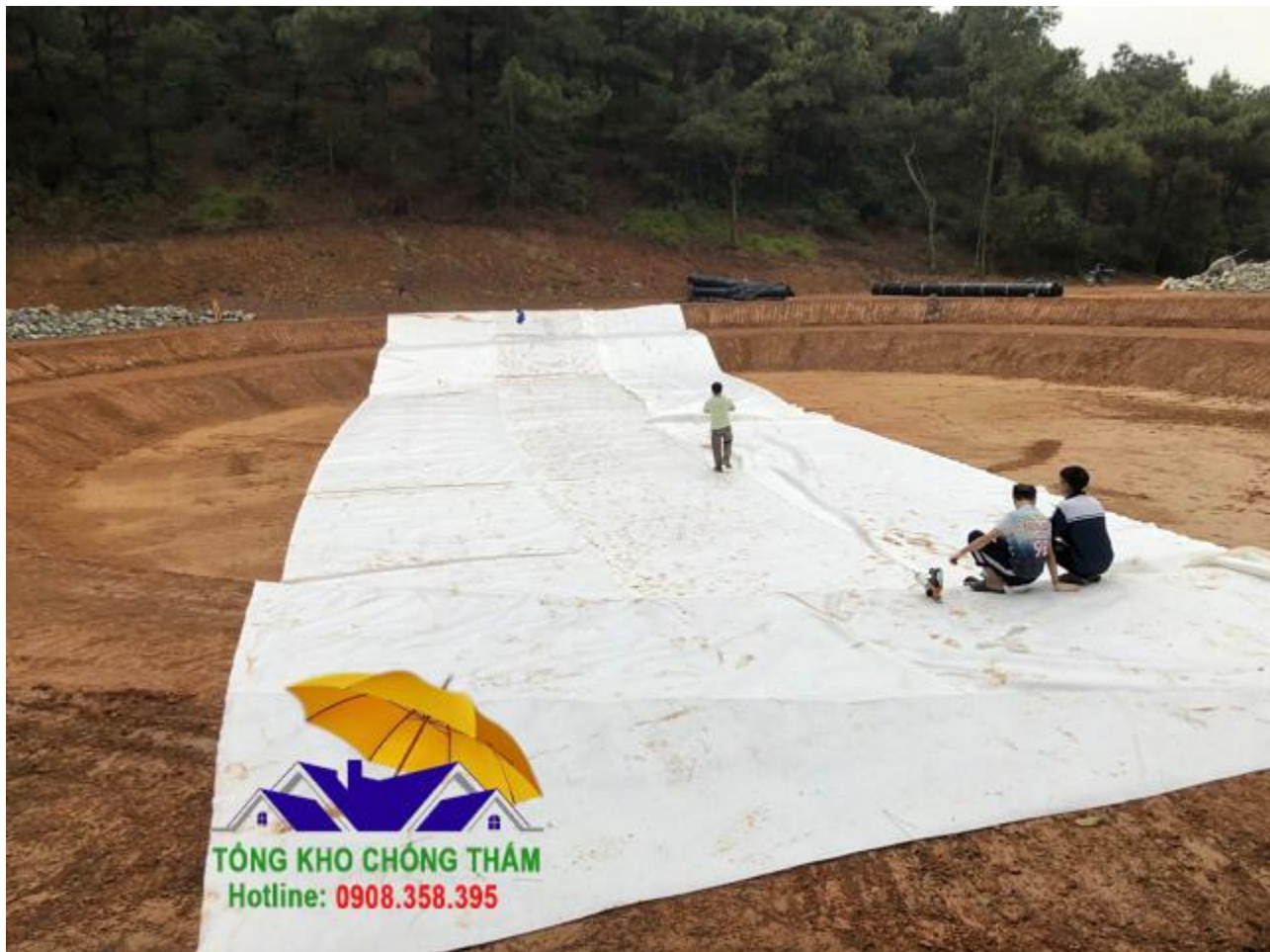
Trải vải địa kỹ thuật
