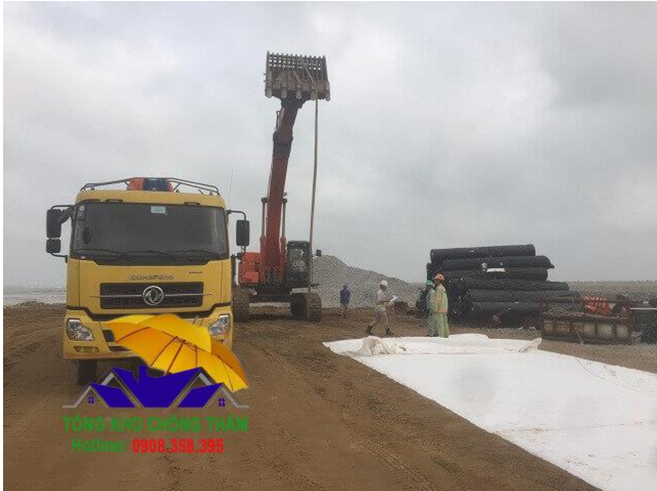
Hình ảnh thi công
