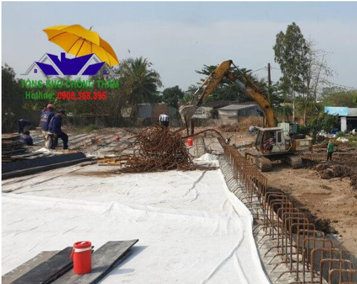
Quy trình thi công vải ART
