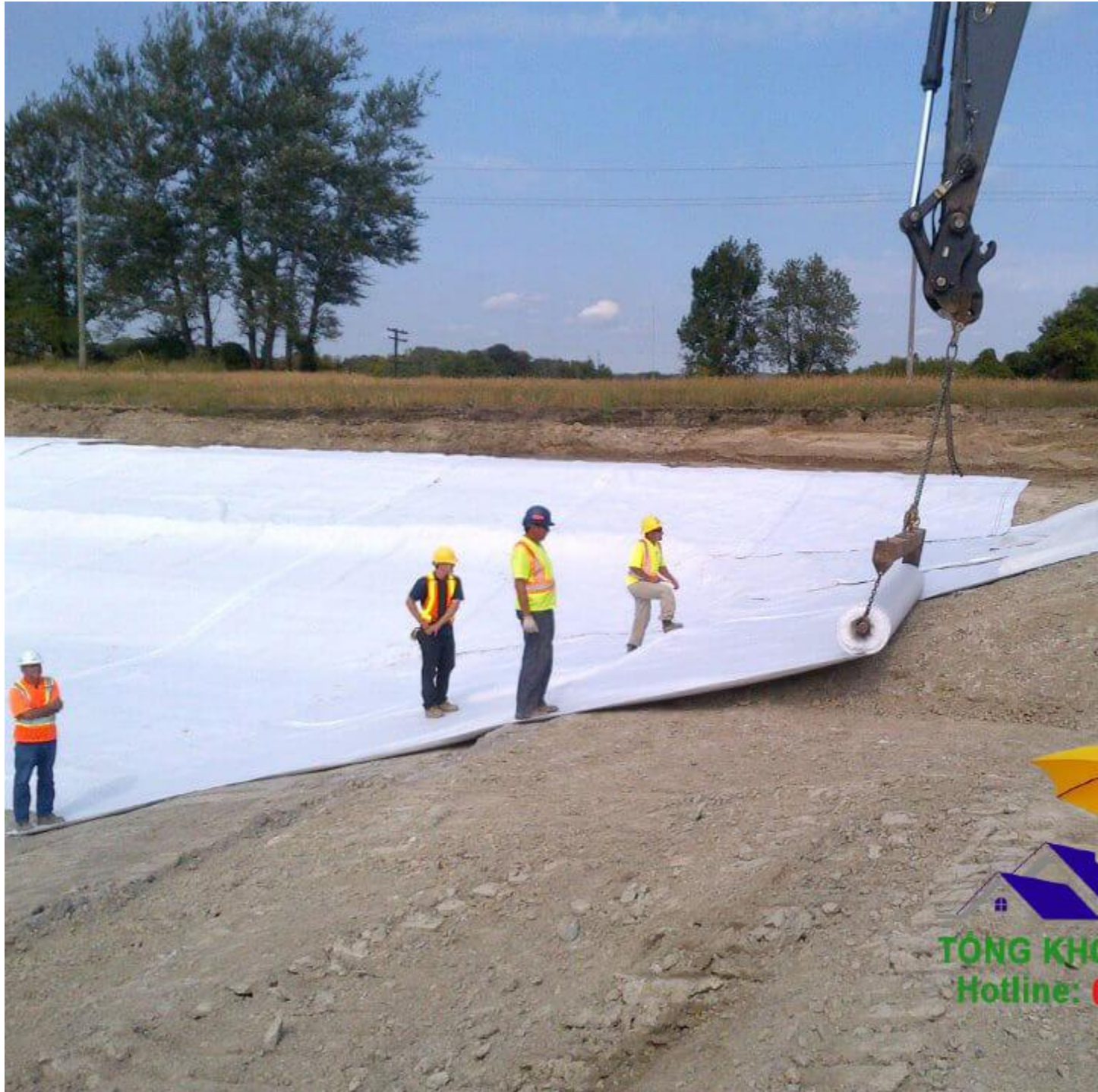
Công tác trải vải địa
