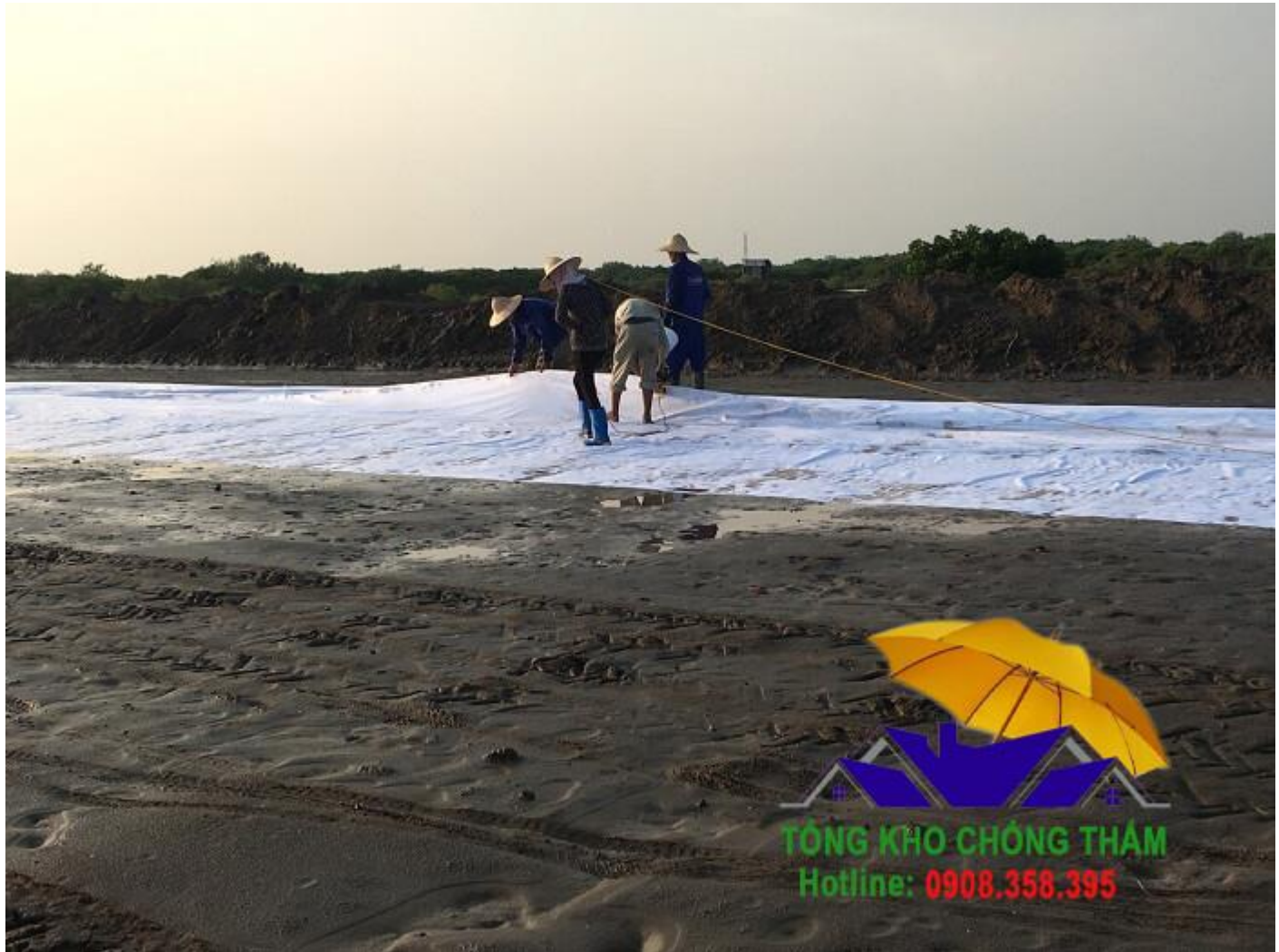
Nối may vải địa kỹ thuật
