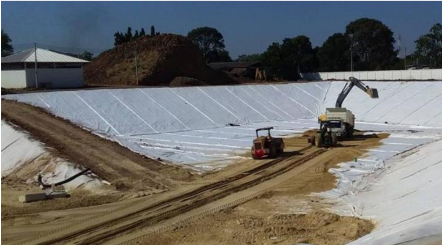
Vải địa kỹ thuật
