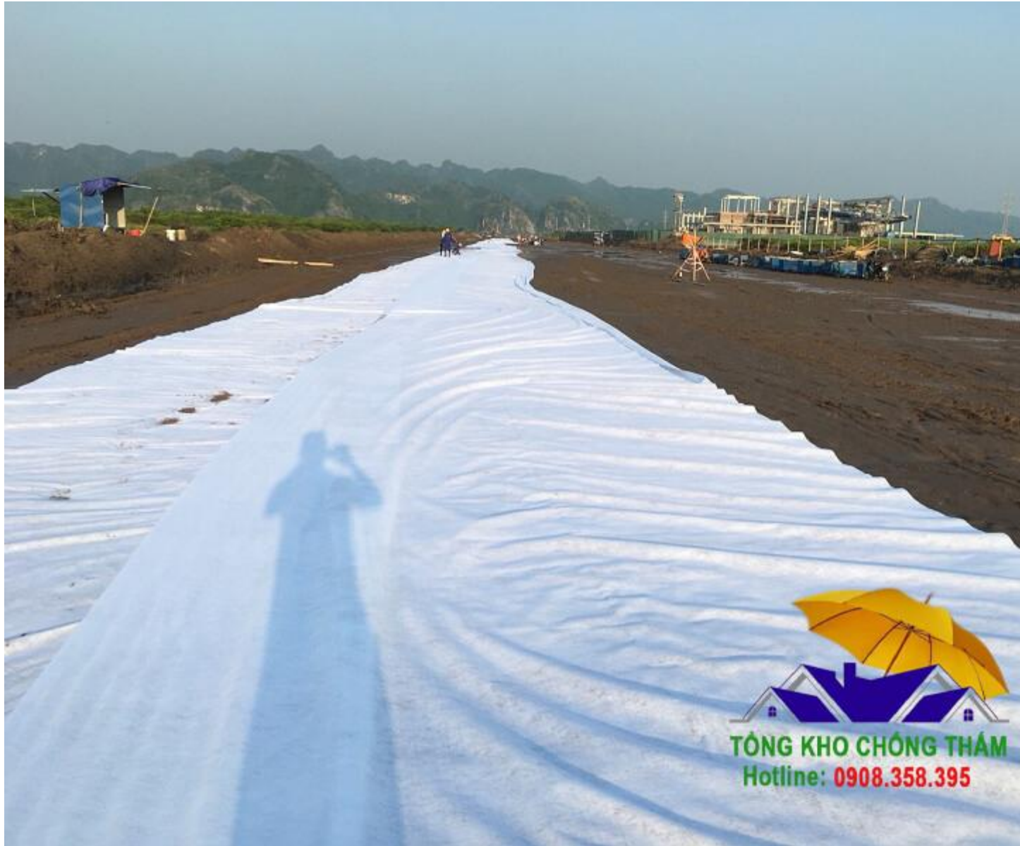
Quy trình trải vải địa kỹ thuật
