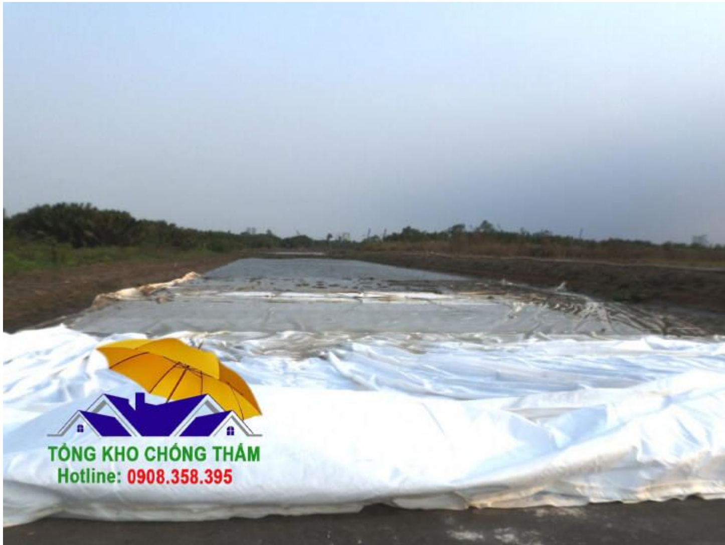
Hình ảnh thi công
